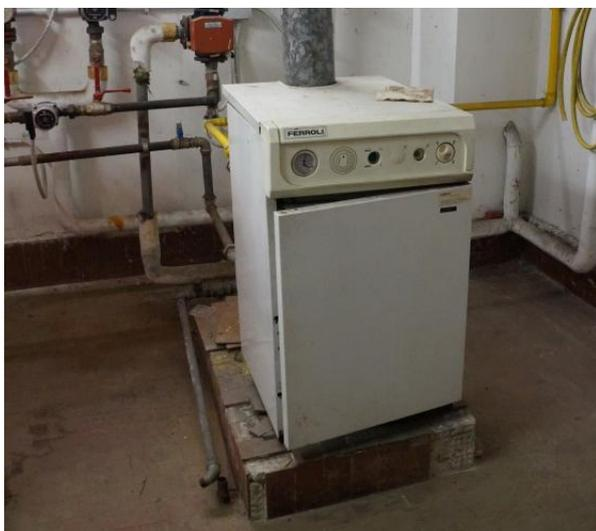
Figura 4.12 - Particolare del generatore di calore
